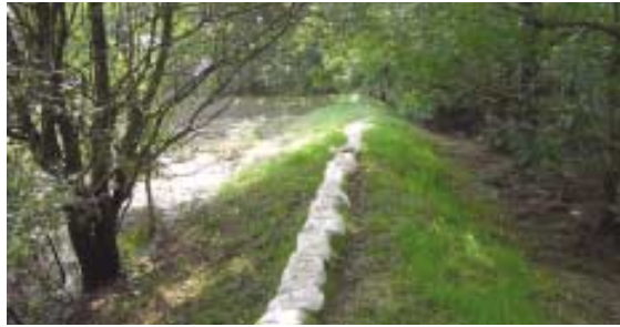
Zu schmale Deichkronen und Bewuchs führen zu einer stärkeren Durchsickerung und Materialaustrag.
