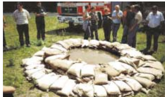
Ringdamm aus Sandsäcken bei einer Übung
